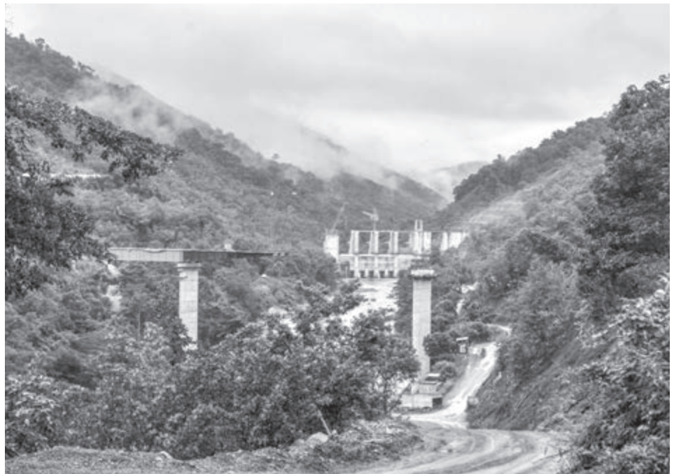
Panorámica hidroeléctrica Oxec. Guatemala, 12.05.2017.
